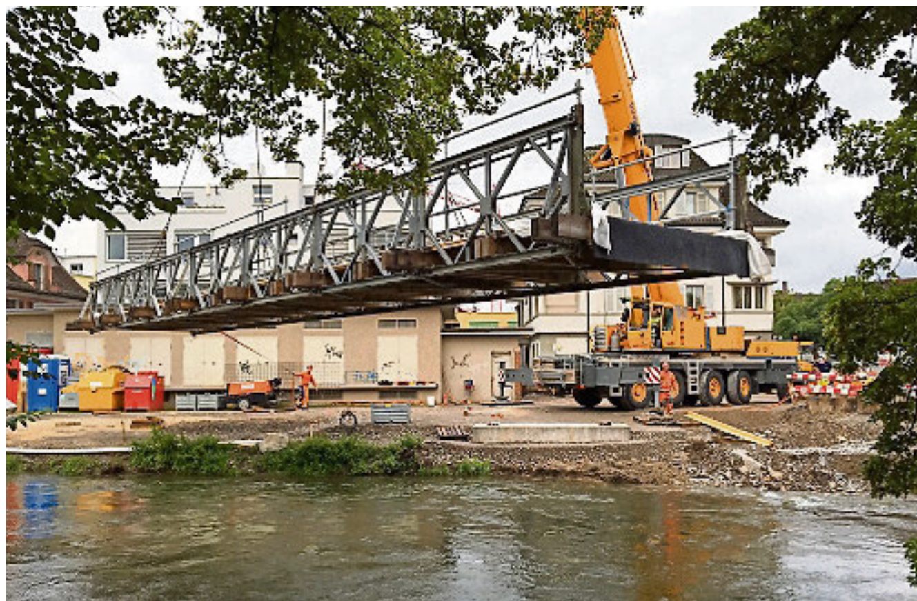
Ein Kran «lupft» die Fussgängerbrücke in einem Stück und stellt sie auf die beidseits der Glatt vorbereiteten Betonsockel. Bild: zvg
