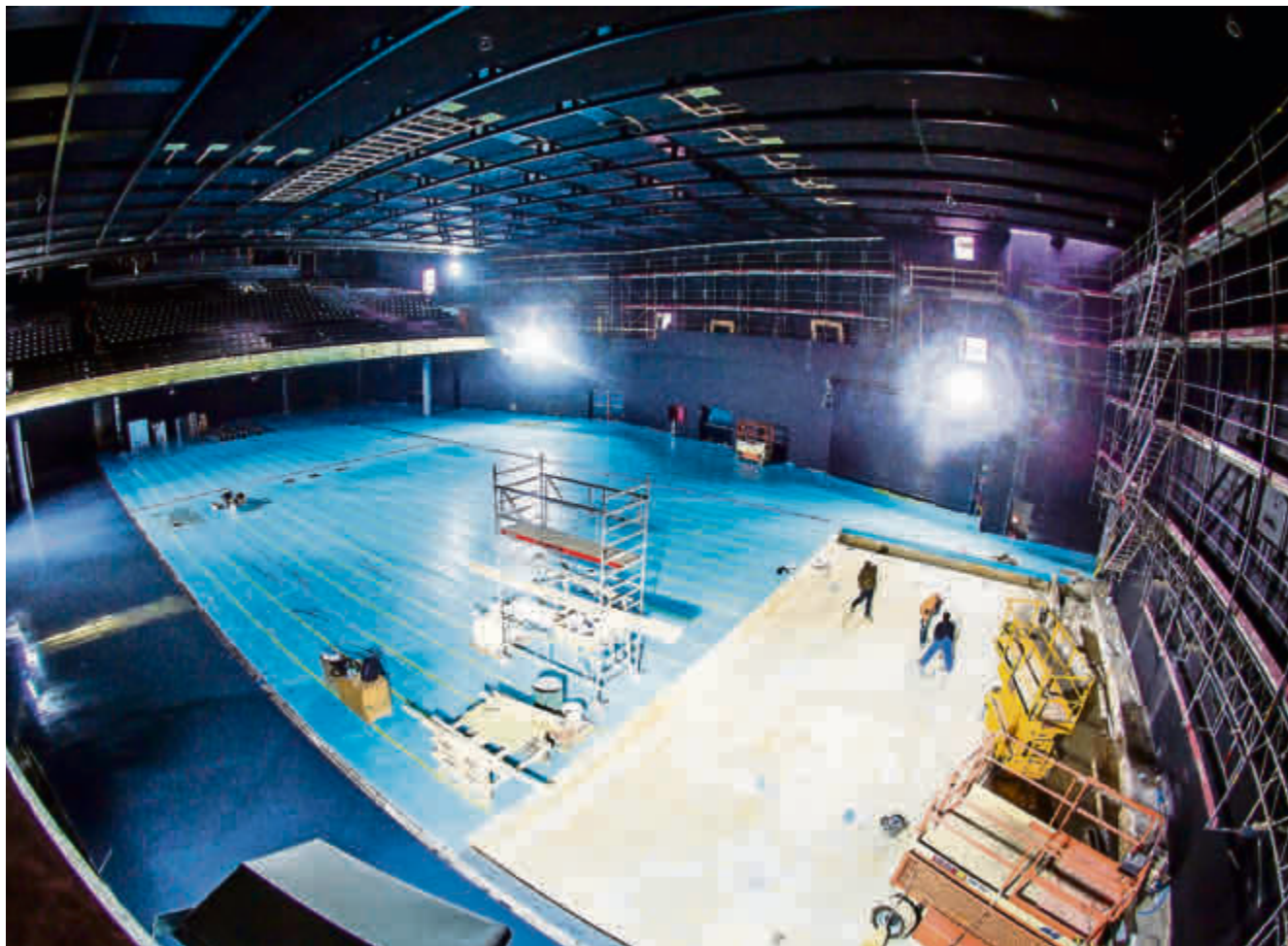
Die Halle ist das Prunkstück der Samsunghall. In diesen Tagen wird die hydraulische Bühne montiert.
